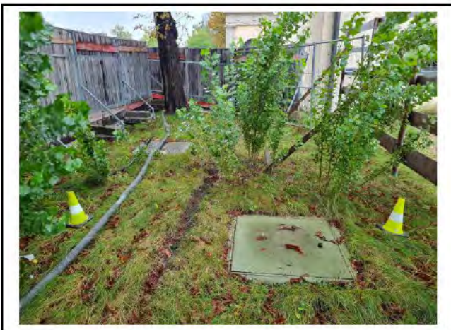
Abbildung 8: Bestehende Schächte, eine Leitung und Eisenstreben
