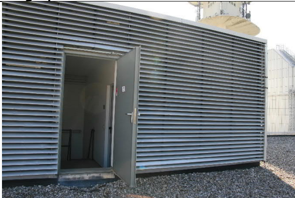
Dachaufbau mit ungeeigneter Verkleidung
