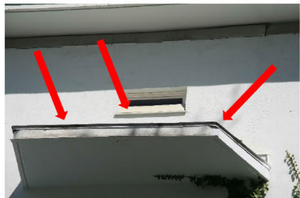
Süd-Fassade; Überstand mit Spalten; Fenster mit lockerer Verdeckklappe
