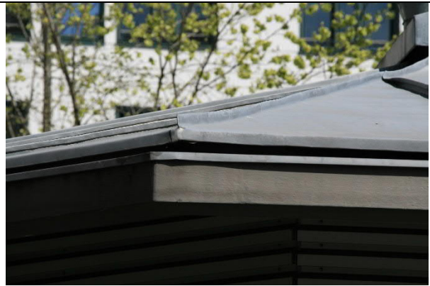
Metall-Dach mit ungeeigneten Spalten
