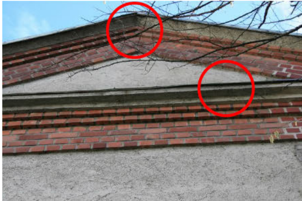
Abb. 11 und 12: Blechabdeckung am Trauf – Spalten nicht breit / tief genug für Quartiereignung
