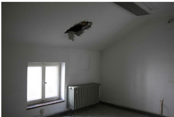
Abb. 7 und 8: Deckenöffnung unter dem Dach (Südseite) zur Untersuchung der Bausubstanz
