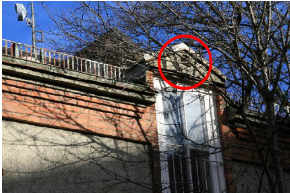
Abb. 13: Loch in einem morschen Balken über dem Balkon
