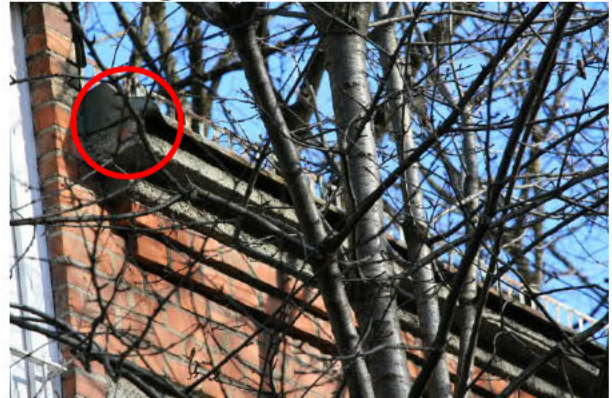
Abb. 11 und 12: Blechabdeckung am Trauf – Spalten nicht breit / tief genug für Quartiereignung
