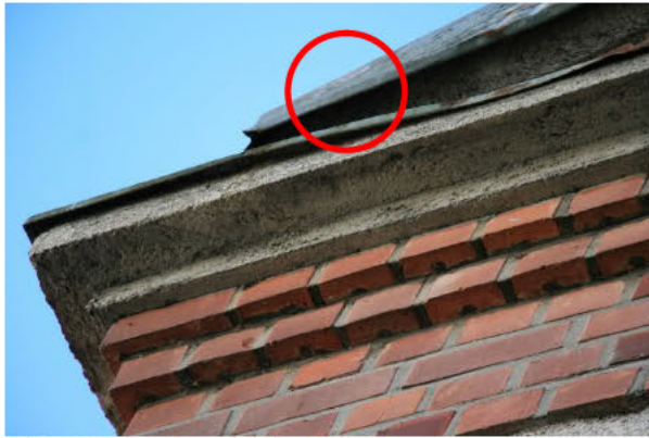
Abb. 9 und 10: nicht einsehbare Spalten an Dachtrauf und Regenrinne
