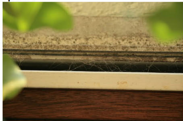
Abb. 12: Spalt am Rolladenkasten
