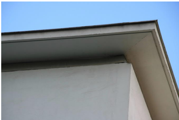
Abb. 15: Dachüberstand Gebäudesüd- / Ostseite ohne erkennbare Öffnungen, an der Ostseite mit Taubenschutz
