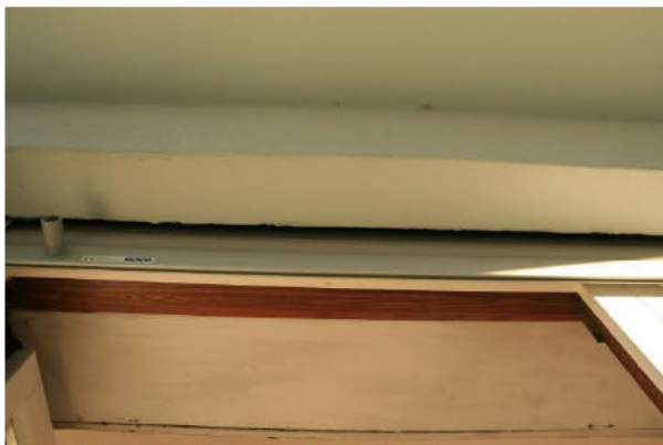
Abb. 11: Spalt am Rolladenkasten, ca. 2 cm breit
