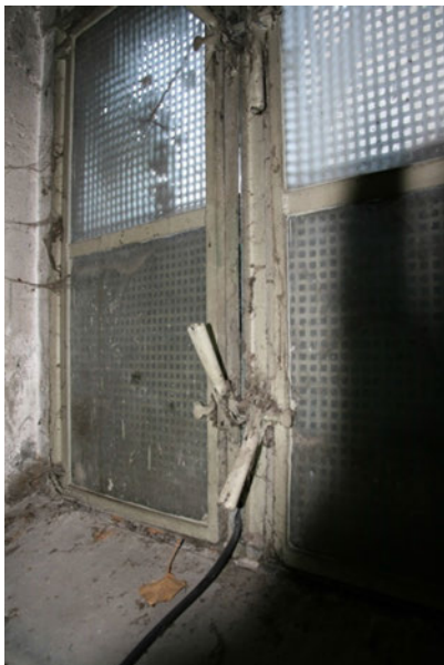
Abb. 3: Kellerfenster mit Kabelöffnung – zu schmal als Eingang für Fledermäuse / Säugertiere (ca. 0,5 cm)
